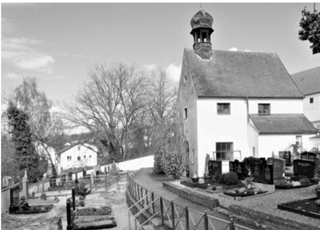
Hier ist der 1926/27 erweiterte westliche Teil des Friedhofs mit dem damals neu gebauten Leichenhaus zu sehen.
